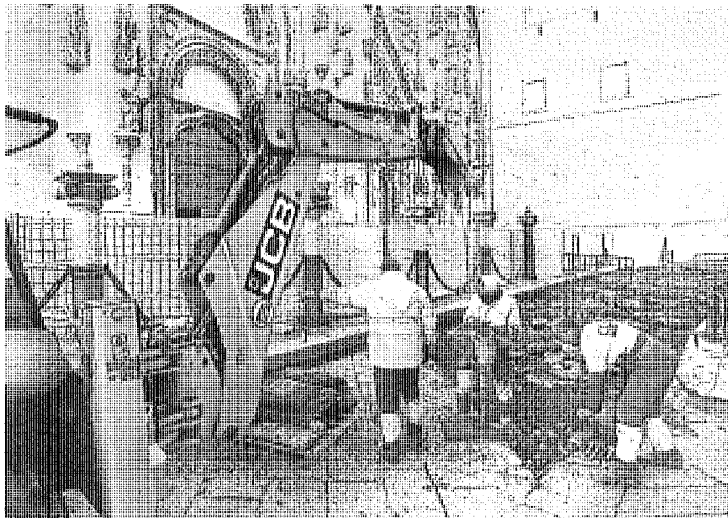
Trabajadores en las obras de accesibilidad en la calle Benedicto XVI junto a la Catedral. | ALMEIDA
